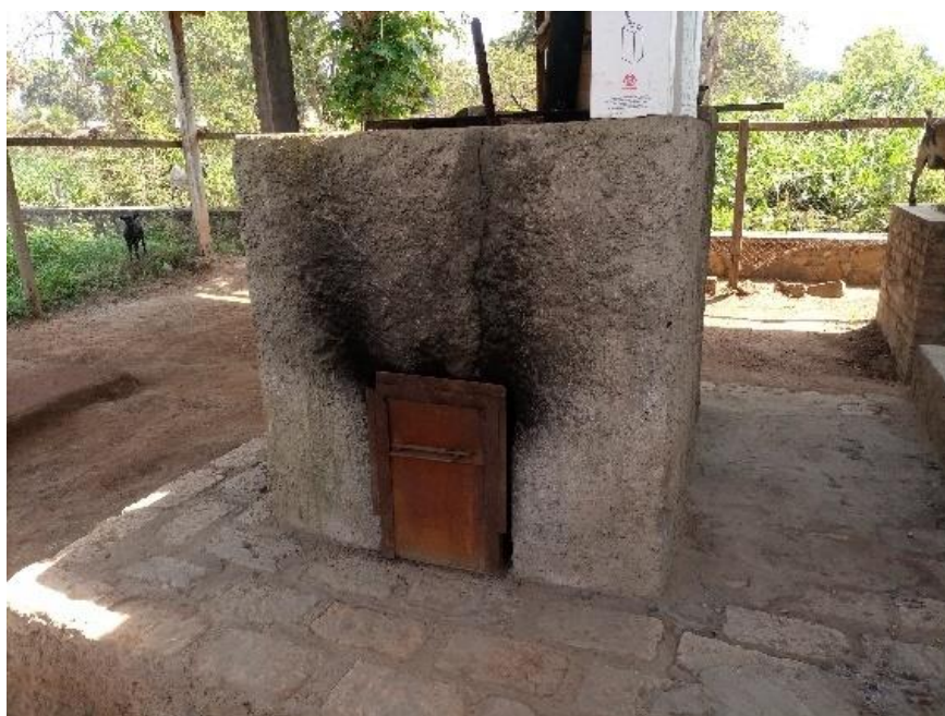
Photo 4. Incinérateur non fonctionnel au sein de l'hôpital de Sibut (MSP, 2022 8 ).
